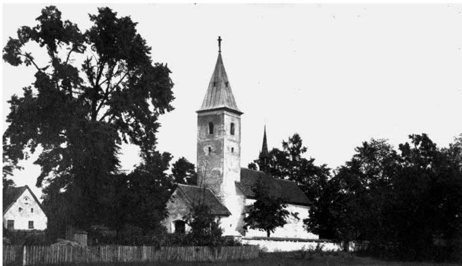
Rys. 10. Wilkowiecko, kościół przed rozbudową 1930 r.
