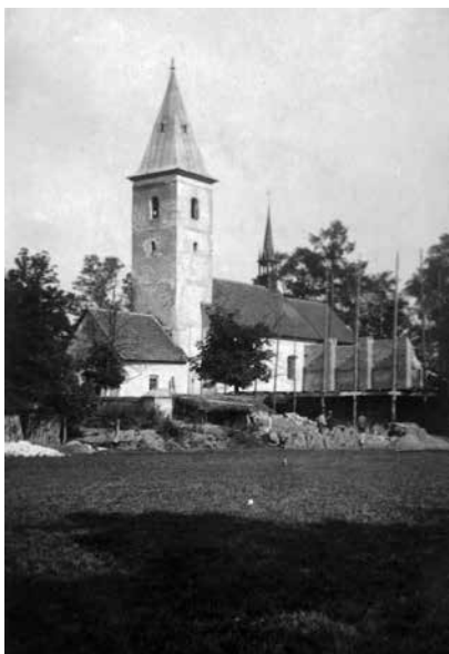
Rys. 12. Kościół w Wilkowiecu, początek rozbudowy 1930 r.
