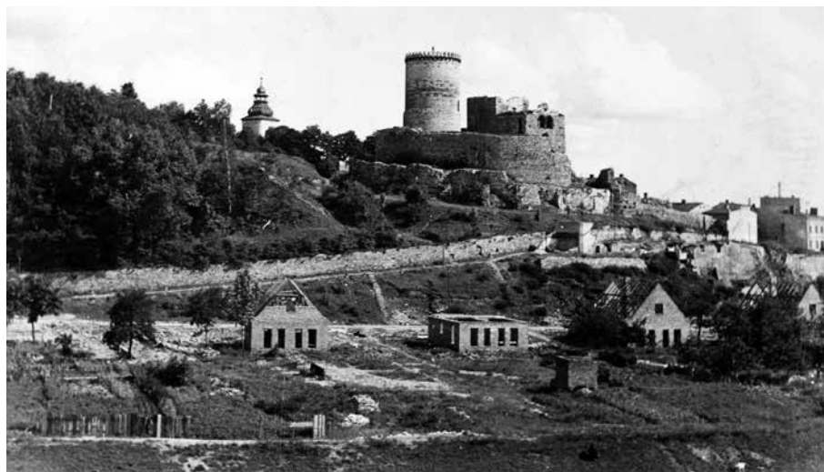
Rys. 3. Budowa nowych domków u podnóża Wzgórza Zamkowego, ul. Podzamcze.
